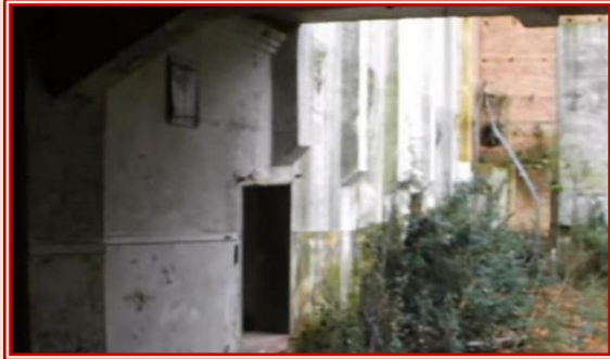
Figura 25 – Acesso a túneis subterrâneos.
